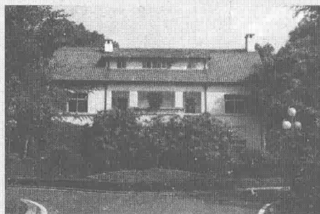
林森公馆(沙坪坝区歌乐山林园4号楼)。
