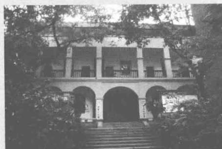
德国领事馆旧址(位于重庆市渝中区和平路原区政府内)。
