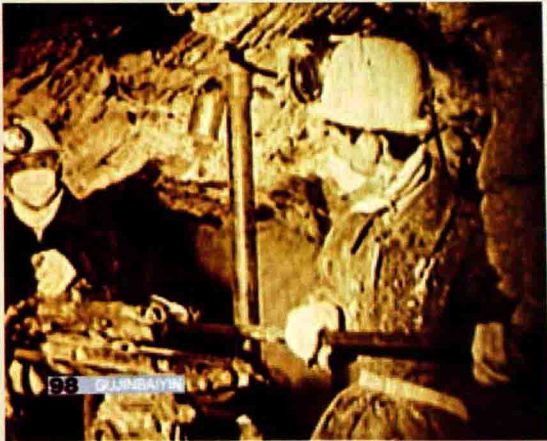
工人们在挖装炸药巷道
