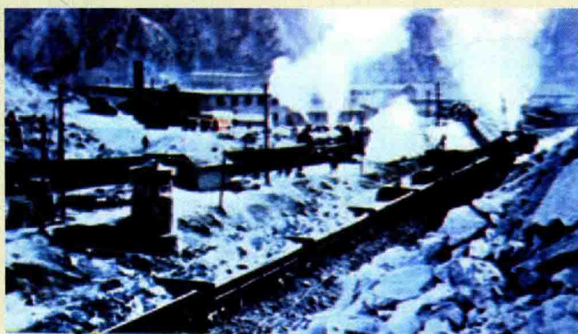
开发建设初期的建设工地
