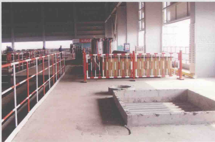
图 A-A01-01 固定式防护栏杆
