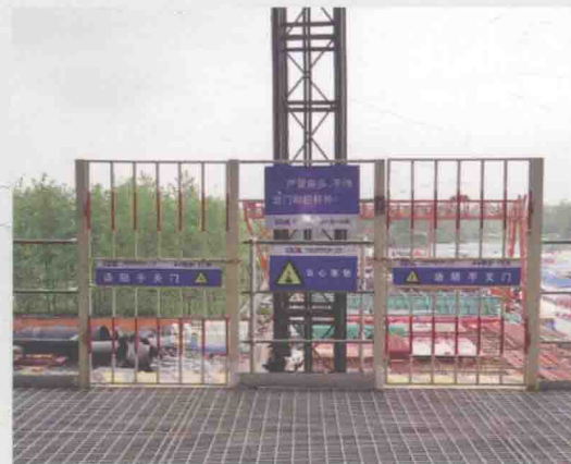
图 A-A04-03 电梯出口通道
