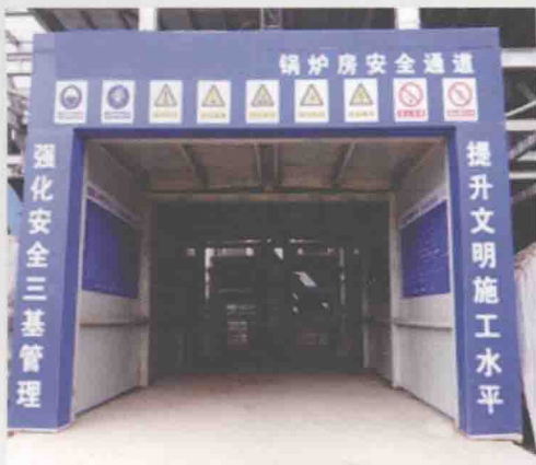
图 A-A04-01 锅炉区域安全通道
