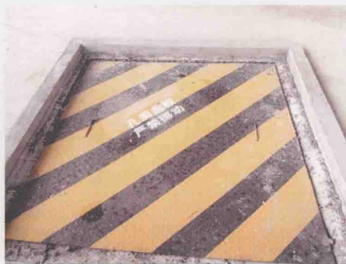
图 A-A05-01 主厂房孔洞盖板 1
