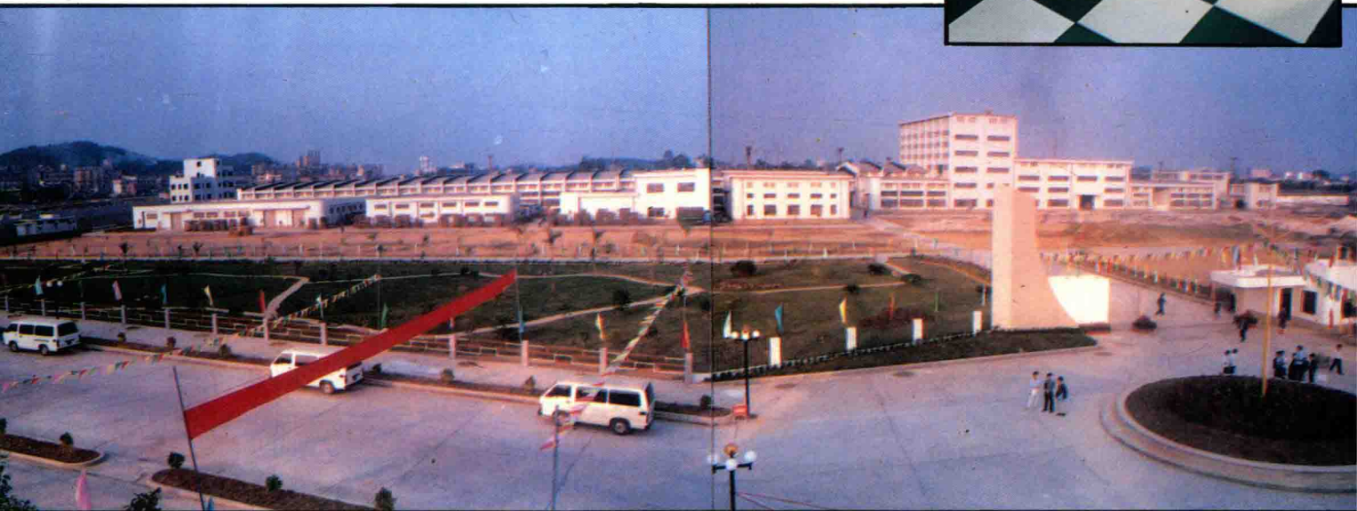
南方牆地磚廠外景
