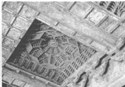
图 1-1-18 元朝建筑内棚顶
