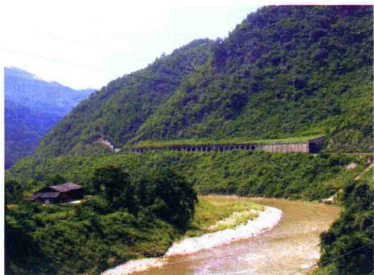
图 1-6 川黔铁路傍山柱式棚洞
