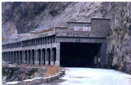
图 1-10 洞口设置抗偏压棚洞
