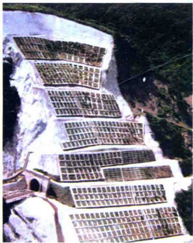
图1-2 大切坡山体格子梁支挡
