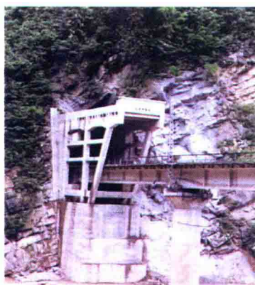
图 1-5 红沙坪隧道出口棚洞
