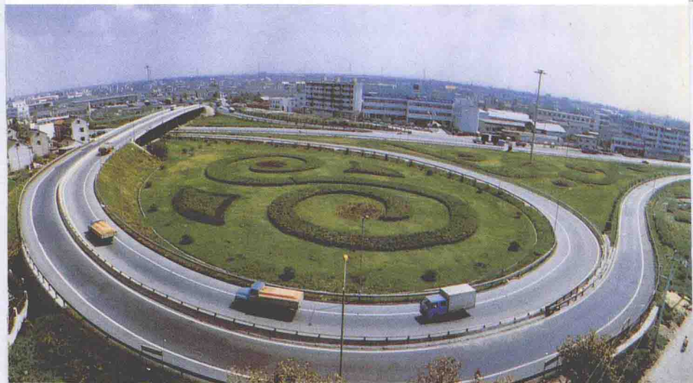
杭甬高速公路起点——杭州互通立交区
