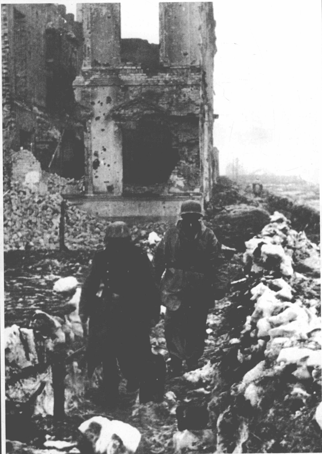
■ 随着积雪的融化，冬季防御工事正在一点点地瓦解，因此德军利用身边的一切材料来构筑新的掩体，例如图中在女子中学废墟附近的阵地上，虽然地面仍然坚硬，但德军还是设法在鹅卵石路面上挖出了一条浅沟，利于隐蔽和通行。
