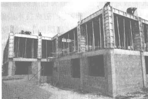
(b) 现场浇筑(柱梁)、现场砌筑(墙体)
