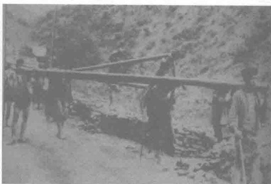
▲ 铺设中印输油管
