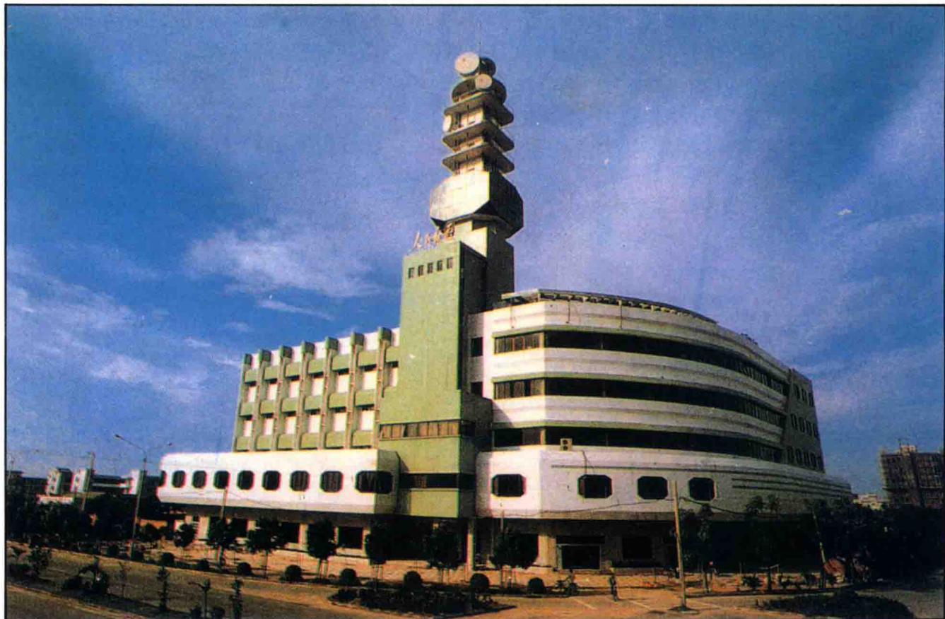
全国最大县改数字通信网——南海市 58000 门程控电话及数字传输系统建成使用
