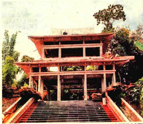
正在翻修的李定国祠
