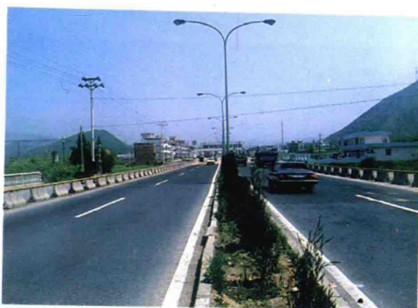
支持扩建 320 国道杭富路工程
