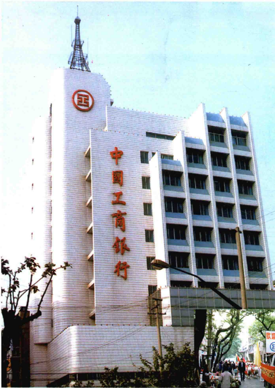
工商银行富阳市支行大楼
