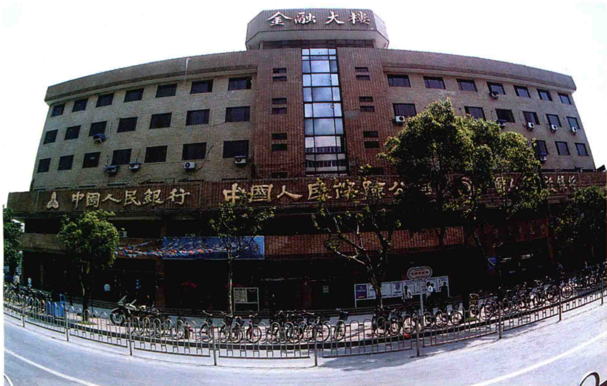
富阳金融大楼
