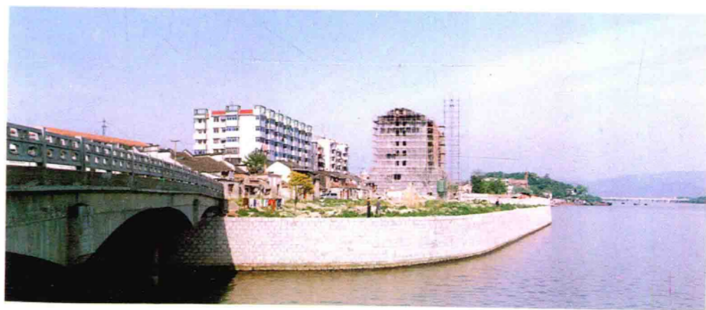
支持富阳镇旧城改造工地一角
