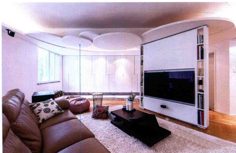
石膏板造型暗藏灯带
