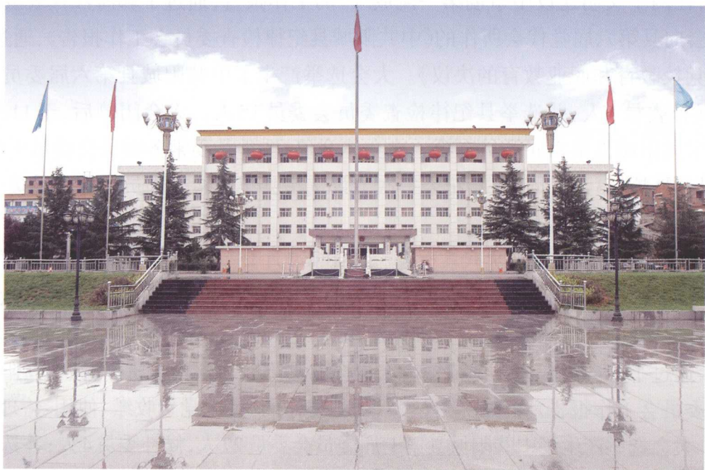
中共阳城县委、阳城县人民政府办公大楼(2008年摄)
