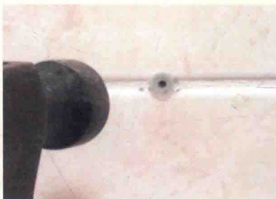
05 | 壁虎完全釘入洞中的情形。若洞不夠深，掛的作品又不會太重時，可以把露出來多餘的壁虎，用美工刀割除。
