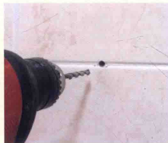
03 | 用電鑽調到震動，換上專門鑽牆壁的鑽頭，在做記號的位置鑽洞。
