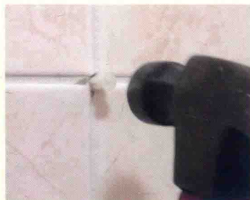
04 | 洞鑽好了，將壁虎釘入洞中。
