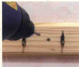
06 | 把要固定的作品以螺絲釘固定在壁虎上的情形。
