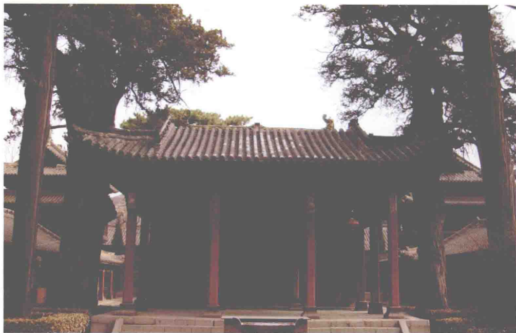
陵川县西溪二仙庙献殿（金代重修），2010年4月5日摄
