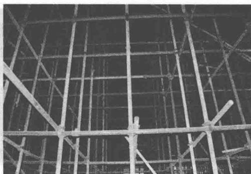
(b) 没有设置剪刀撑
