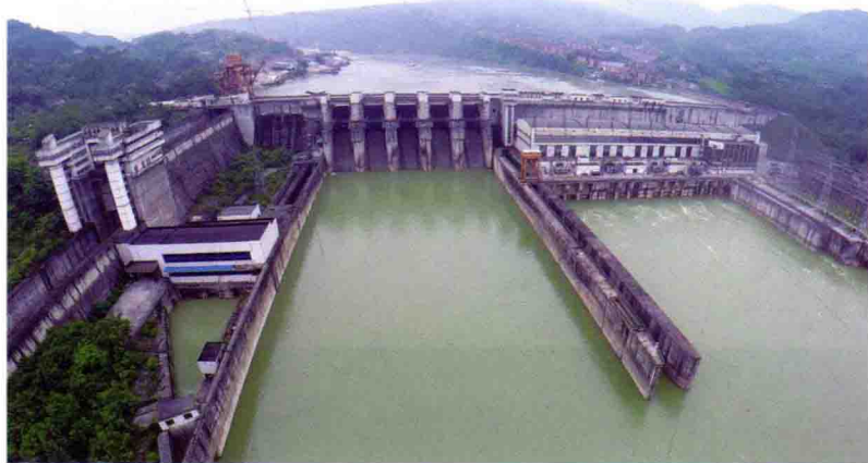
铜街子水电站
