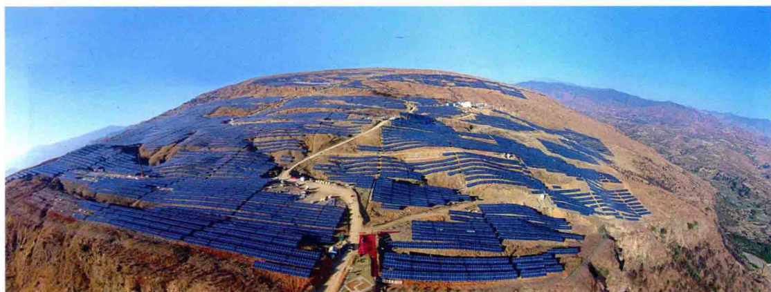
攀枝花万家山光伏电站
