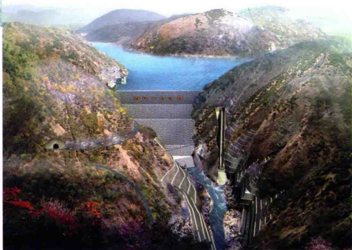
两河口水电站(在建)
