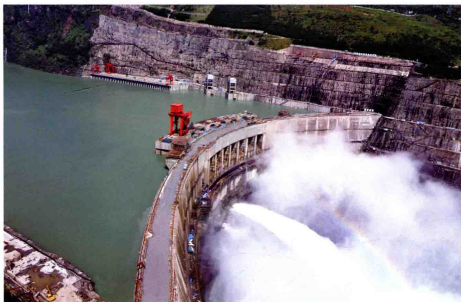
溪洛渡水电站
