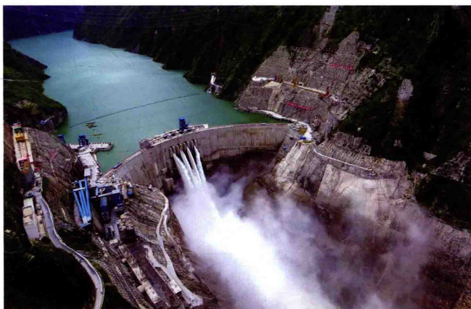
锦屏一级水电站
