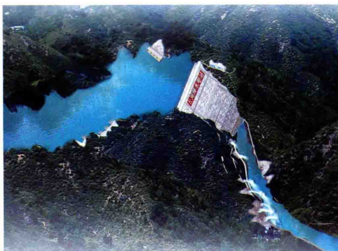
长河坝水电站(在建)
