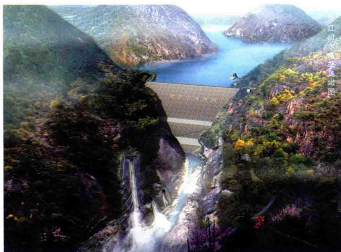
双江口水电站(在建)
