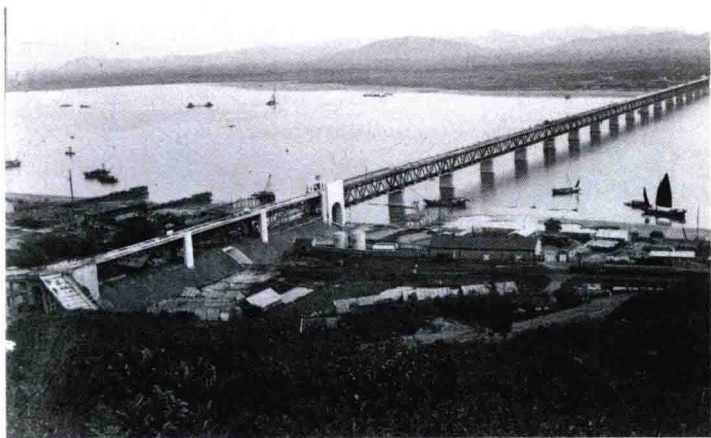
1937年9月刚建成的钱塘江桥
