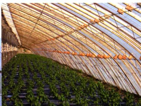
● 彩图8 钢管竹木混合结构温室
