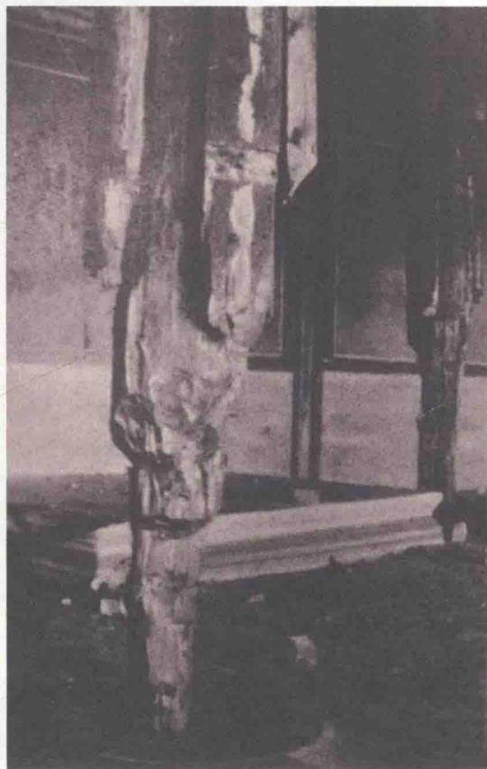
一根木柱被剥离了包在外面的金帛，而且大部分木材被砍去当柴烧了
