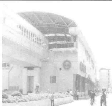
a) 站桥合一车站(上海地铁2号线)
