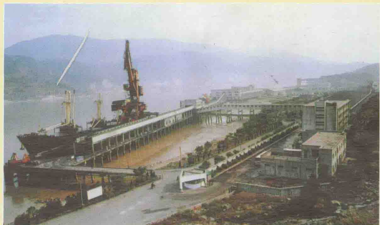
■ 福州港松门港区煤码头
