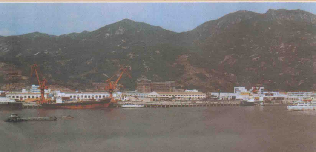
■ 福州港青洲新港区
