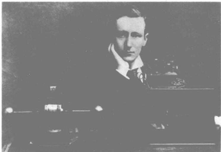
图 1.1 马可尼于 1896 年取得第一张无线电专利证后，与机器合影，时年 22 岁，照片左方是火花发射机，右方是接收机，下方两根横金属条是天线
