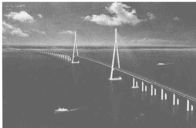
图 1-12 苏通长江公路大桥
