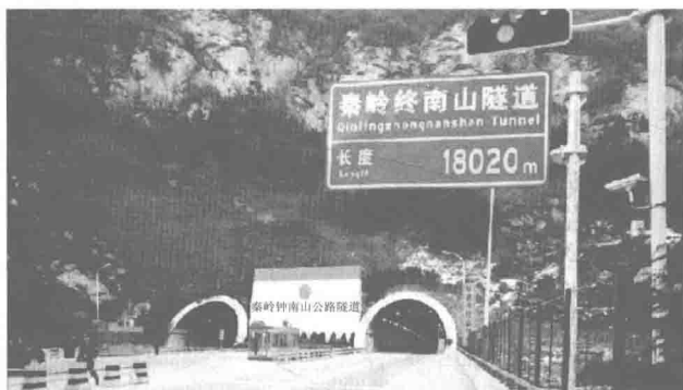
图 1-11 秦岭终南山隧道
