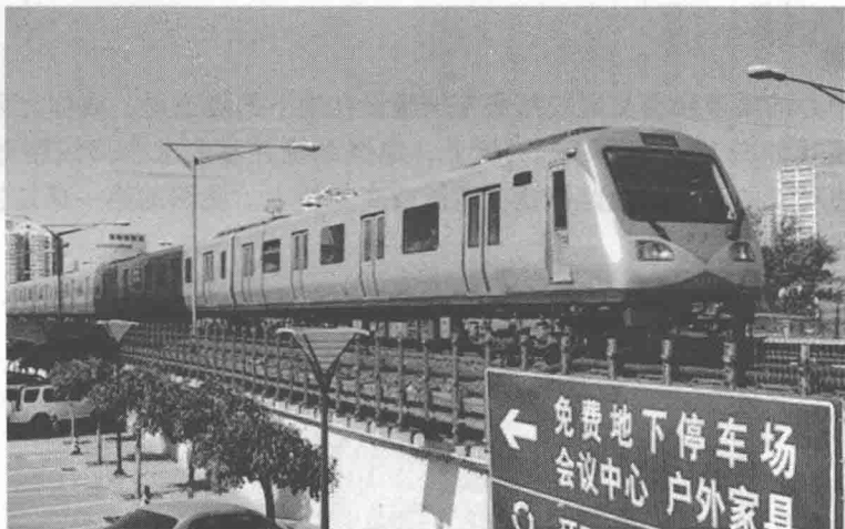
图1-3 轻轨系统——北京地铁13号线
