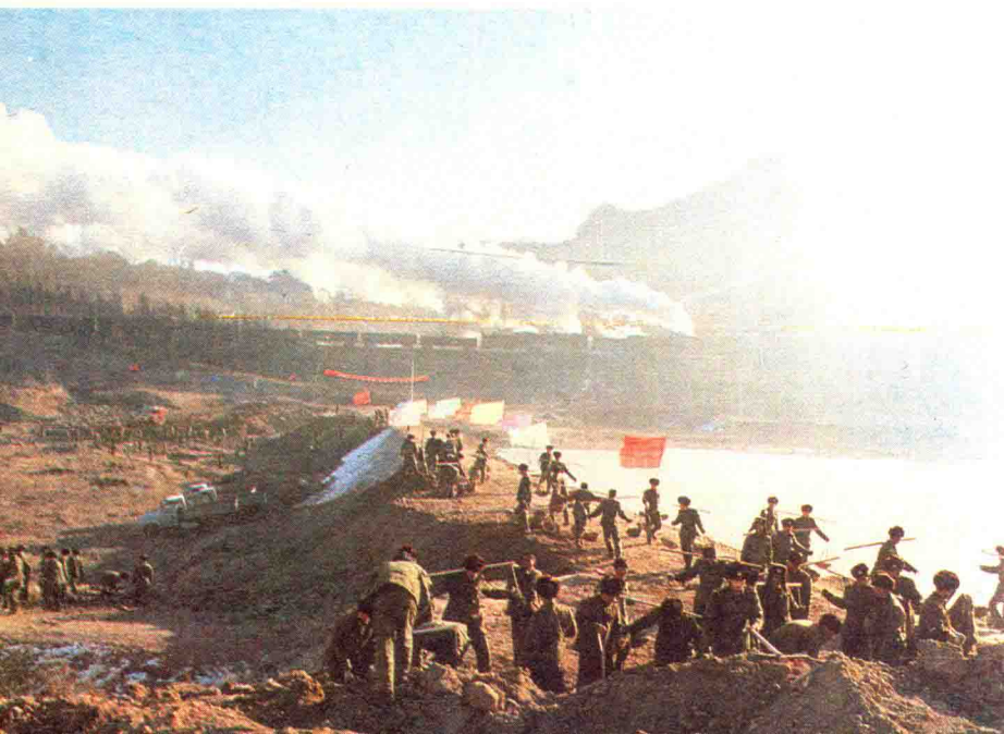
驻军某部指战员冒着零下30多度的严寒，帮助柳河县修筑西腰沟水库大坝。
