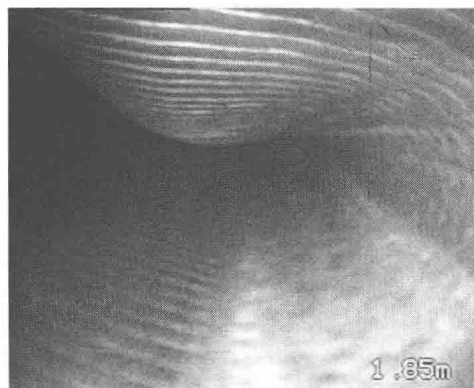
图 1.1-3 管道变形
