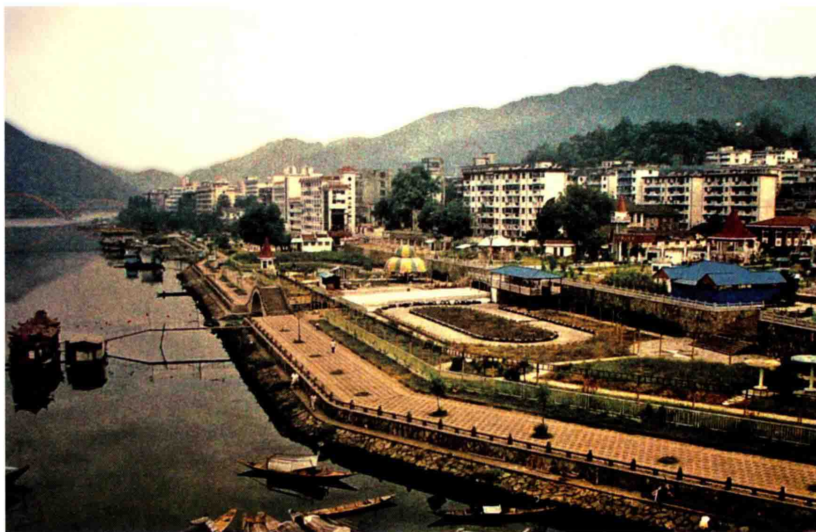
1998年完成的新安江城防一期工程
