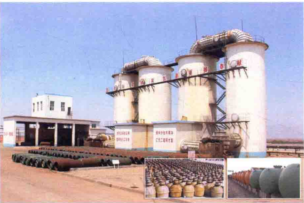
20世纪80年代后期至2005年，山东溴素产量一直占全国总产量90%以上。图为山东海王化工股份有限公司溴素厂一角
