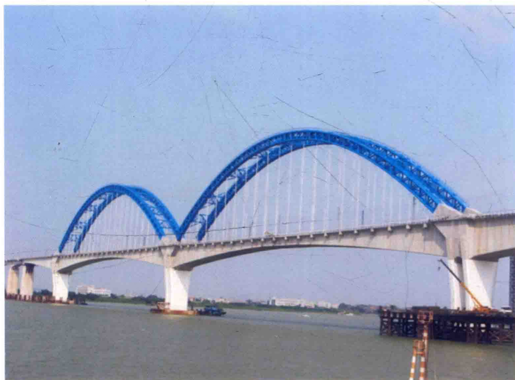
西江特大桥建成后全景
