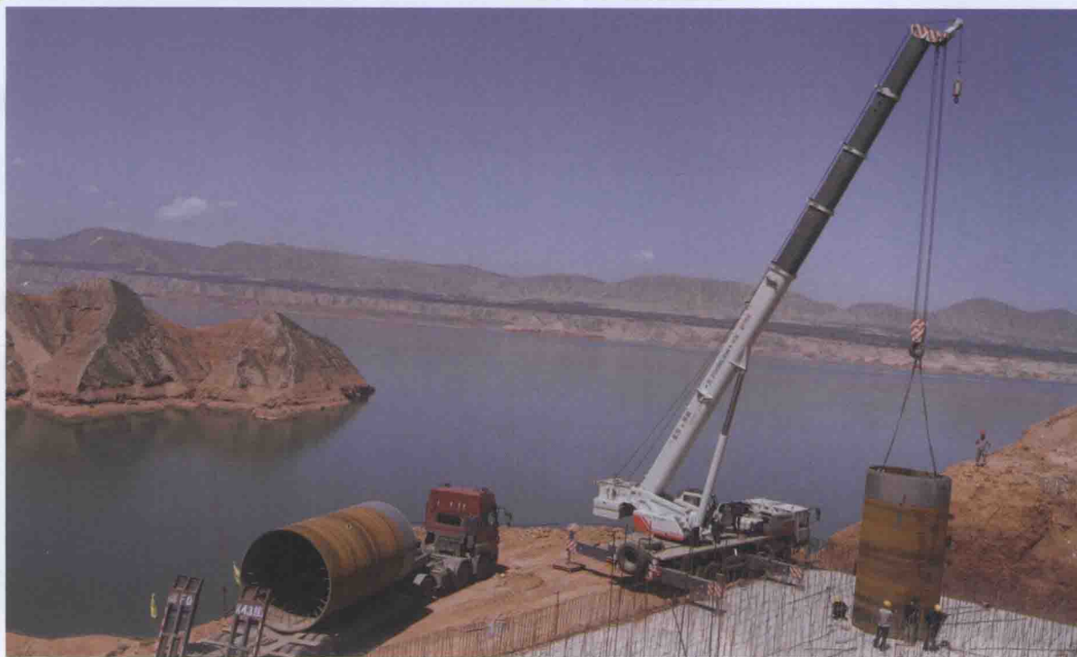
↑ 桥塔首节断钢管安装
