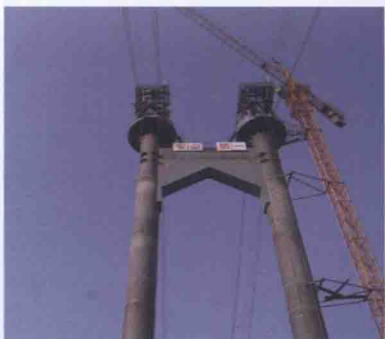
↑ 猫道变位钢架安装
