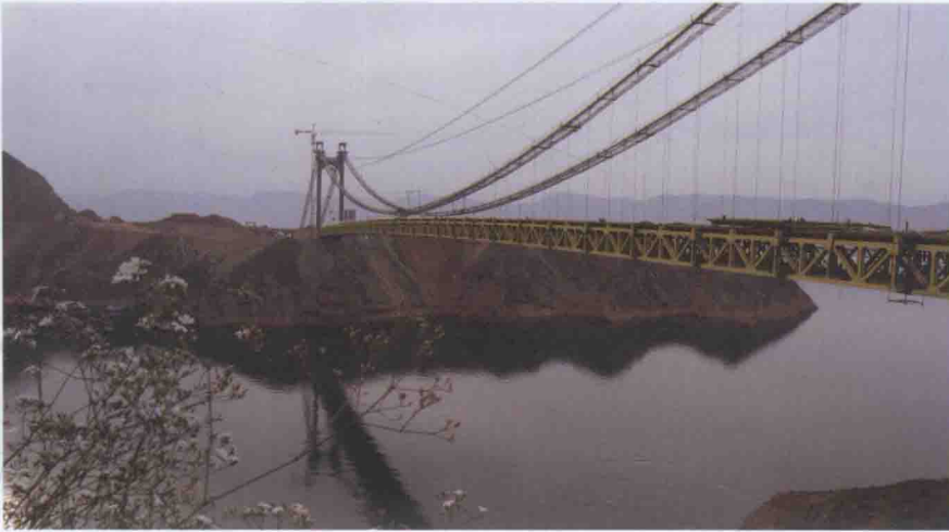
← 正交异性钢桥面板安装
