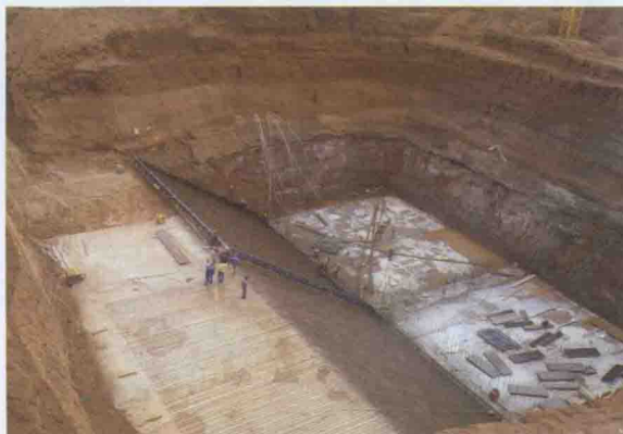
↑ 锚碇抗硫混凝土垫层施工
