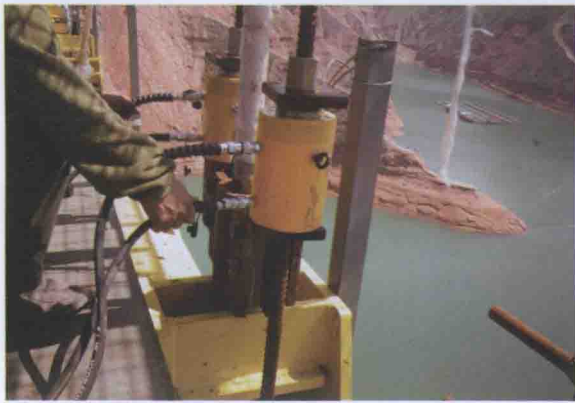
↑ 钢桁架梁线形调整
