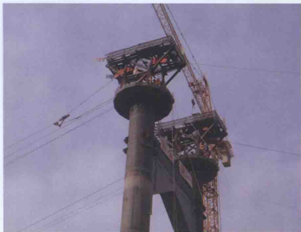
↑ 猫道承重索牵引
