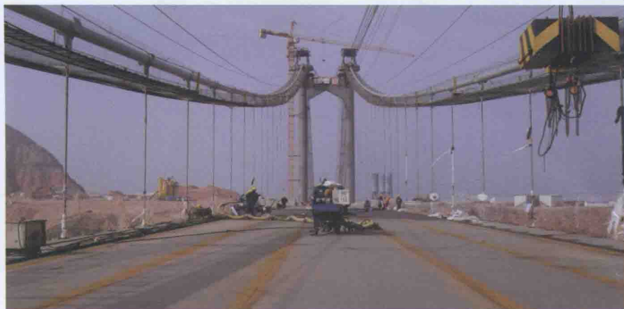
桥面板喷砂除锈施工 →
