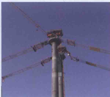
↑ 猫道面网施工
