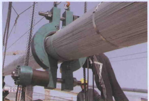
↑ 主缆紧缆施工
