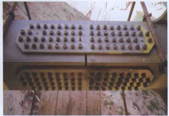
↑ 钢桁架梁节点联接
