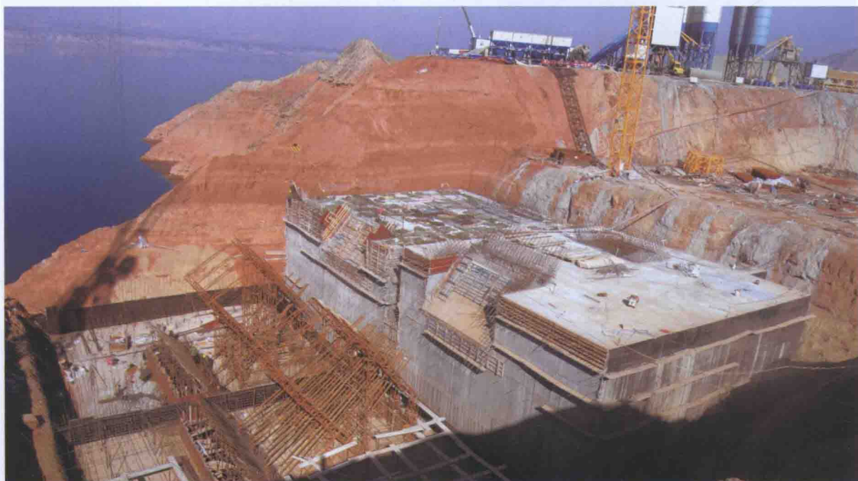
↑ 锚碇混凝土分层分块施工
