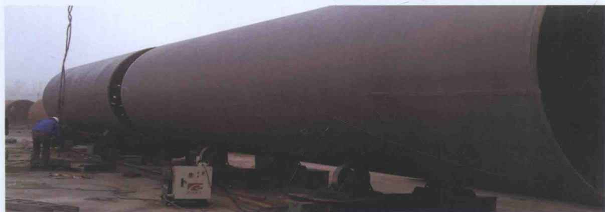
↑ 桥塔钢管制造、拼装
