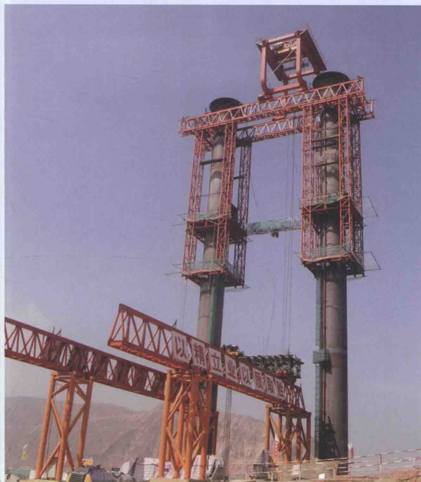
← 自爬升门架安装桥塔
