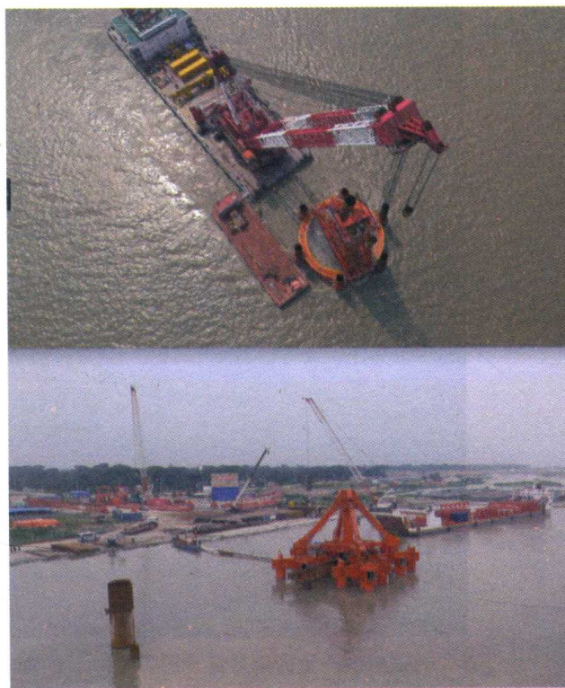
» 帕德玛大桥施工现场
