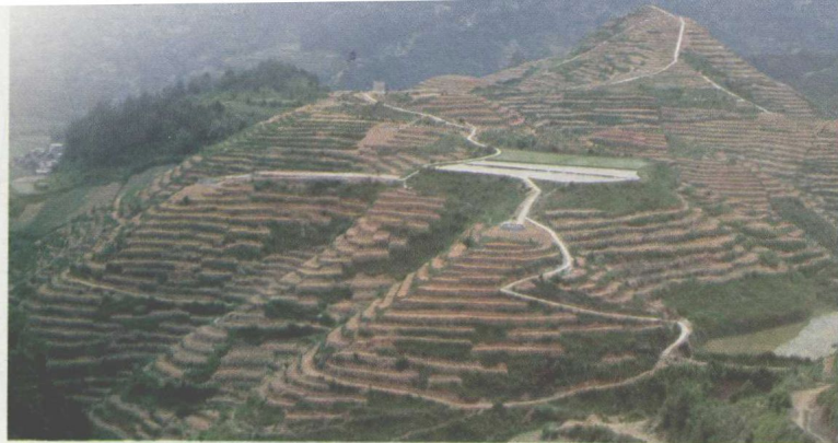
黎平县茶园坡改梯工程
