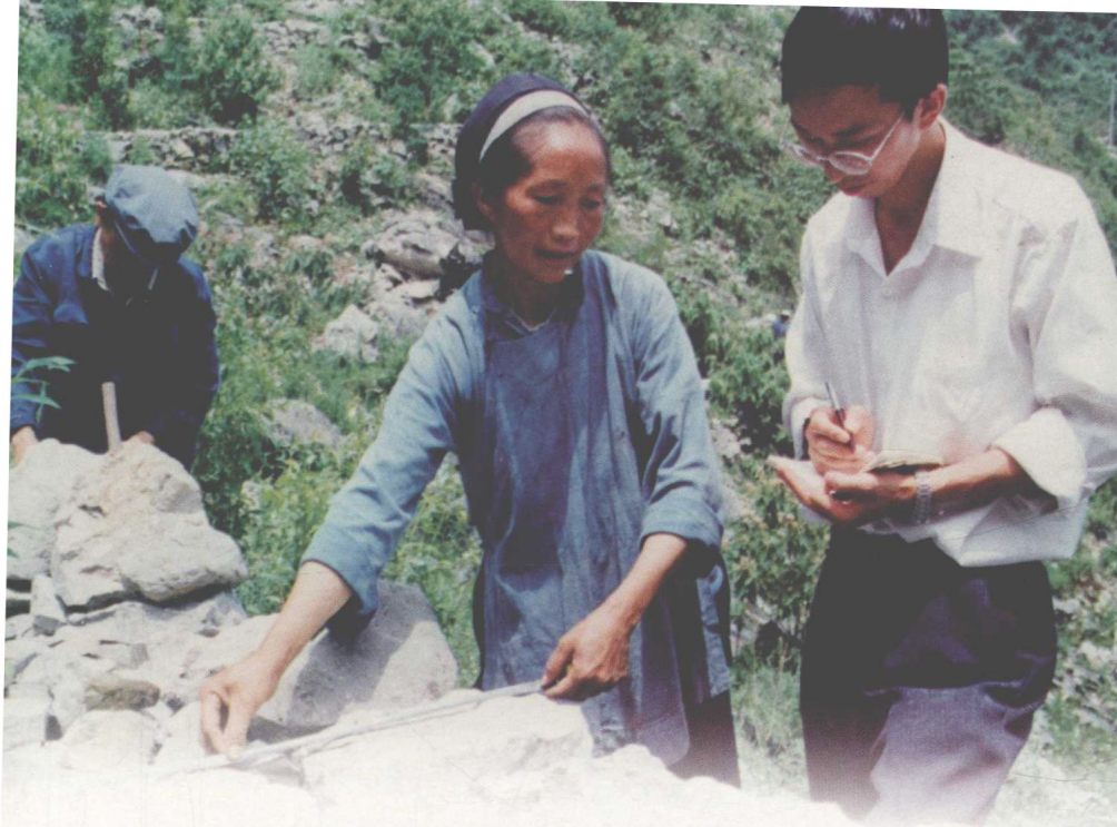
安顺市坡改梯施工现场
