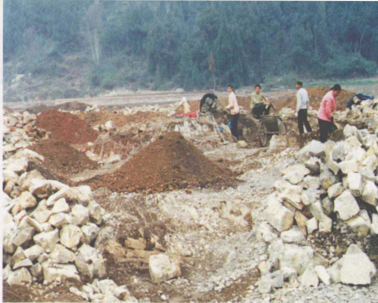
兴义市敬南镇十里坪坡改梯施工现场
