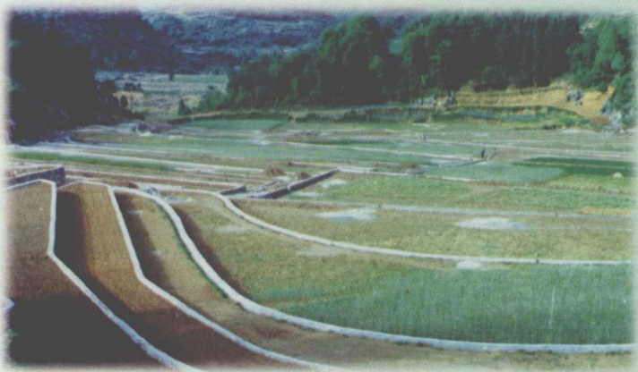
盘县保田镇马甲坡改梯工程
