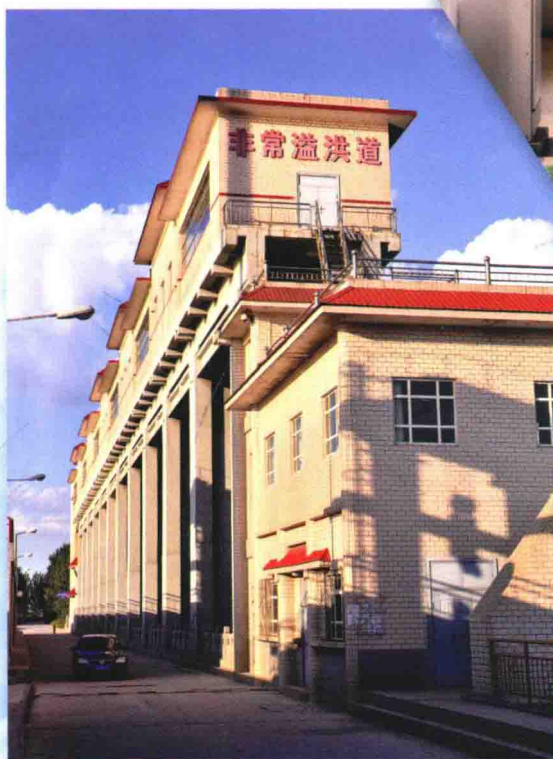
雄伟的非常溢洪道
