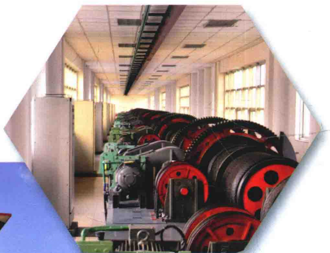
非常溢洪道机房
