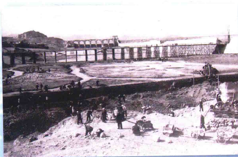
正常溢洪道建设
