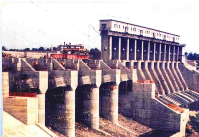
新增非常溢洪道建设
