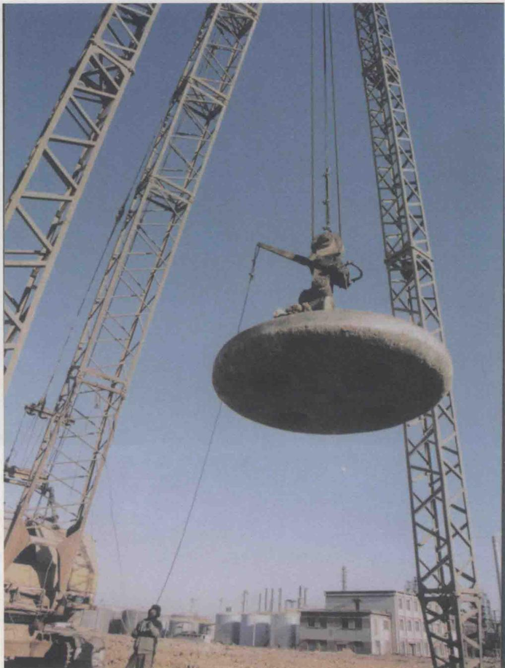
2001年冬天，350万吨/年催化裂化装置建设工地平整完地基后，开始夯实地基作业。这套装置当时属于亚洲最大的装置。这是个新闻点，当时我经常跑工地，熟悉每个建设进展的节点。这张图片也刊发在不少媒体。
