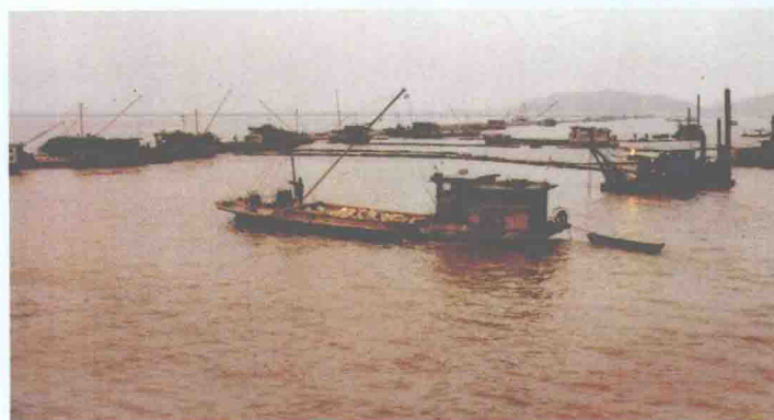
番禺市围垦区施工现场
