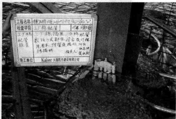
图 1.4-2 在混凝土浇筑前，电气预埋管应管口密封，管身绑扎钢筋网上
