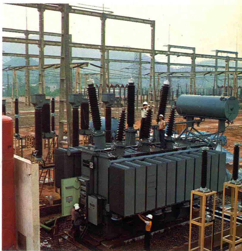
220 千伏變電站正在加緊安裝
