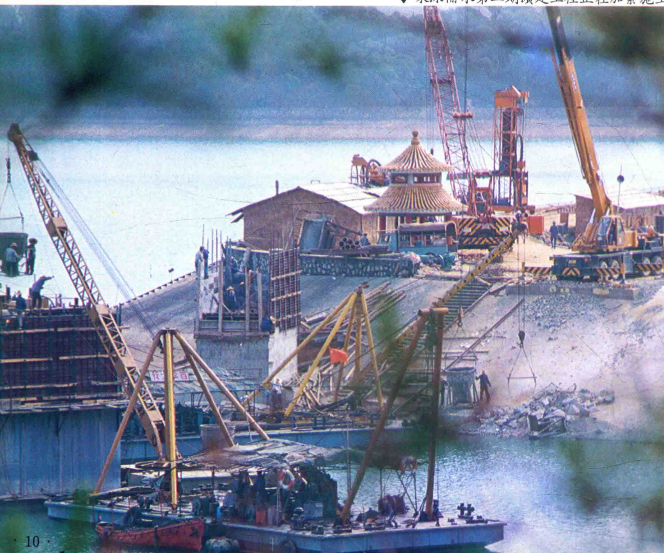
↓ 東深輸水第二期擴建工程正在加緊施工
