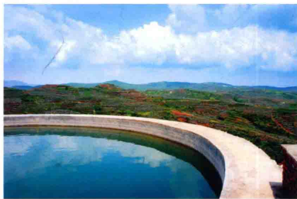
■ 山区石榴园蓄水工程（曹尚银 提供）
