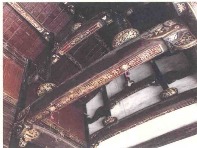
图1-8 江西景德镇玉华堂梁架雕饰
