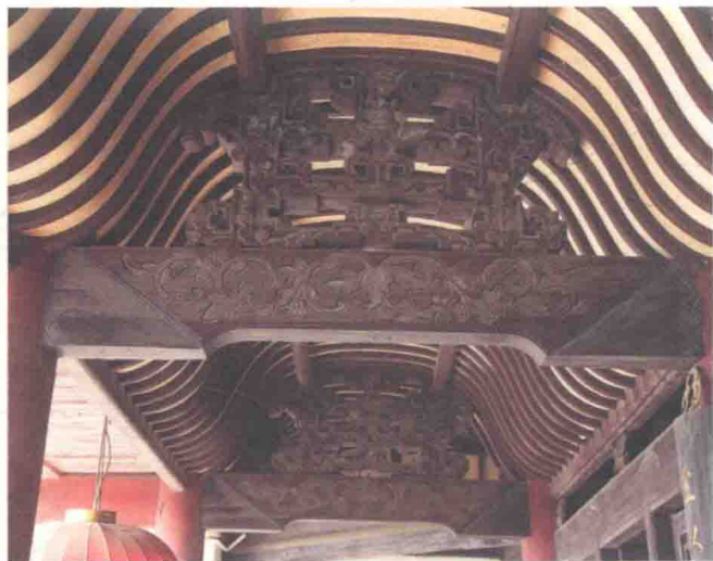
图1-12 广西柳州某宅正厅廊步梁架
