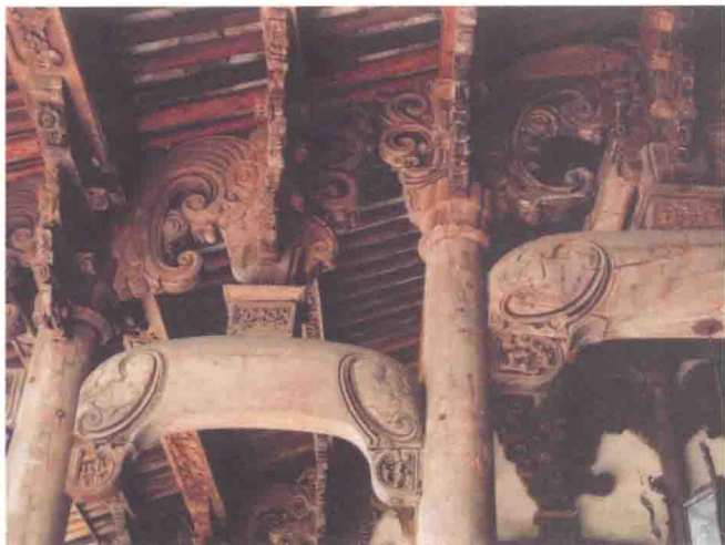
图1-2 浙江东阳卢宅大堂梁架
