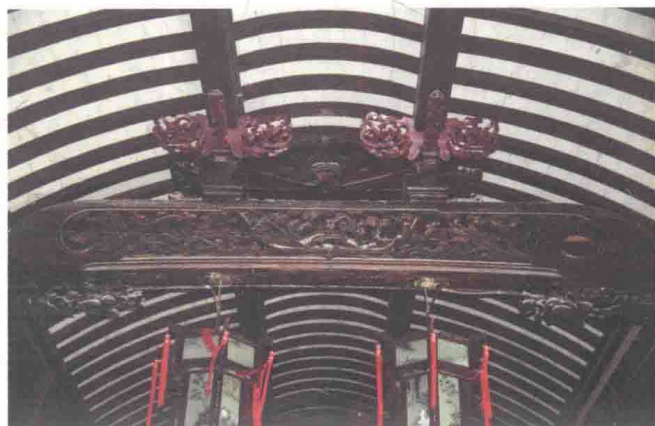
图1-5 江苏无锡薛福成故居大厅梁架
