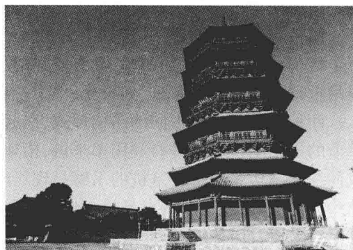
图 1.2 山西应县木塔
