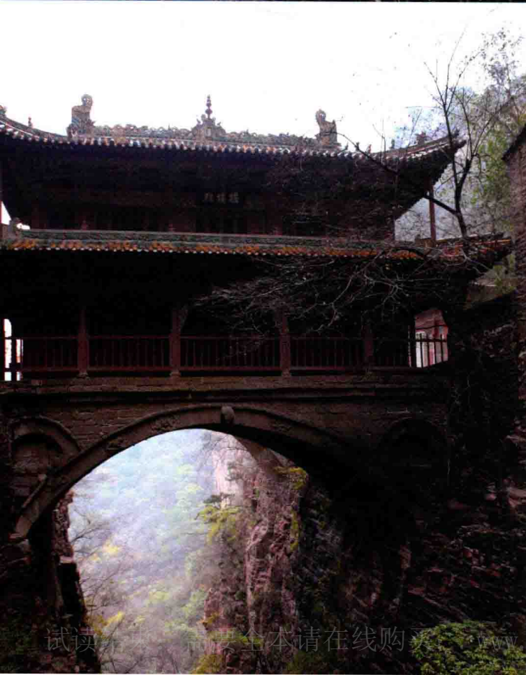
河北井陉苍岩山桥楼殿
