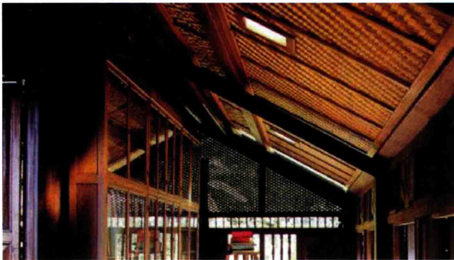
图 2-10 斜屋顶与顶棚中使用的极具特色的竹编材质
