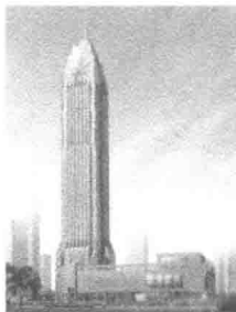
图 1-4 混凝土结构超高层建筑
