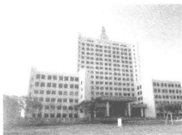
图 1-3 混凝土结构高层建筑
