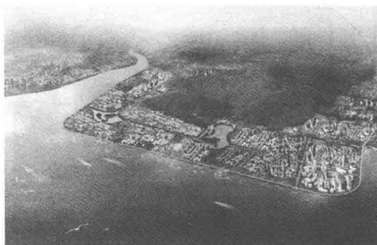
图 1-7 平阳中期围垦工程
