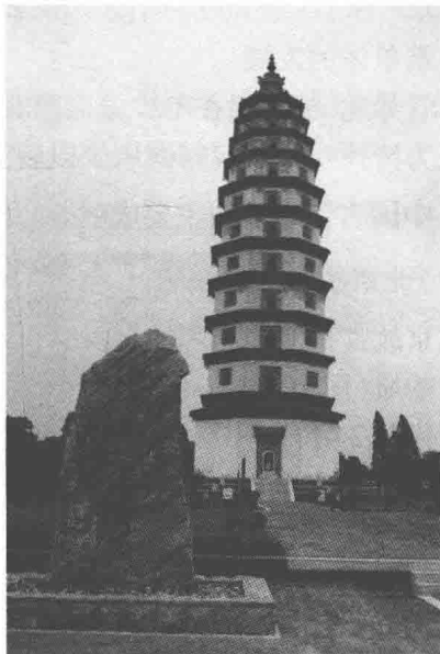
图 1.15 河北定县开元寺料敌塔
