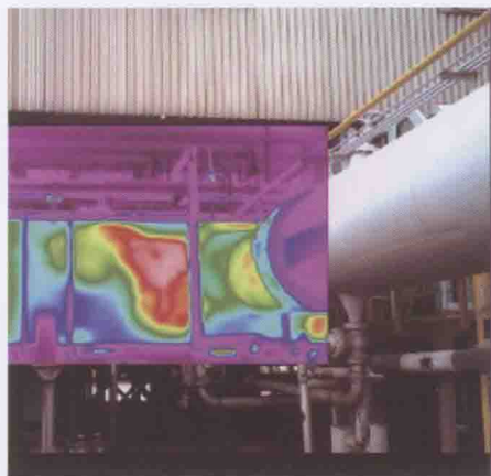
图 3.16 焦油煤气管道检测
