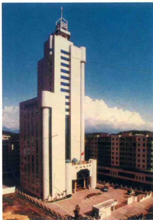
▲ 一建集团公司承建的台山供电调度综合楼被评为江门市优良样板工程。
