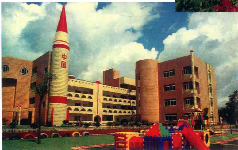
◀二建集团公司承建的台山马兰芳幼儿园被评为省优良样板工程。
