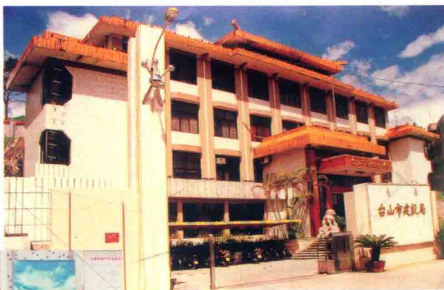
▲ 建设局办公楼。
