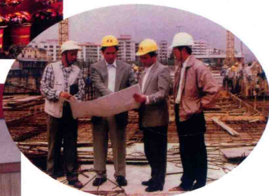
▲ 建设局局长马立平（左二） 等领导深入工地了解情况。
