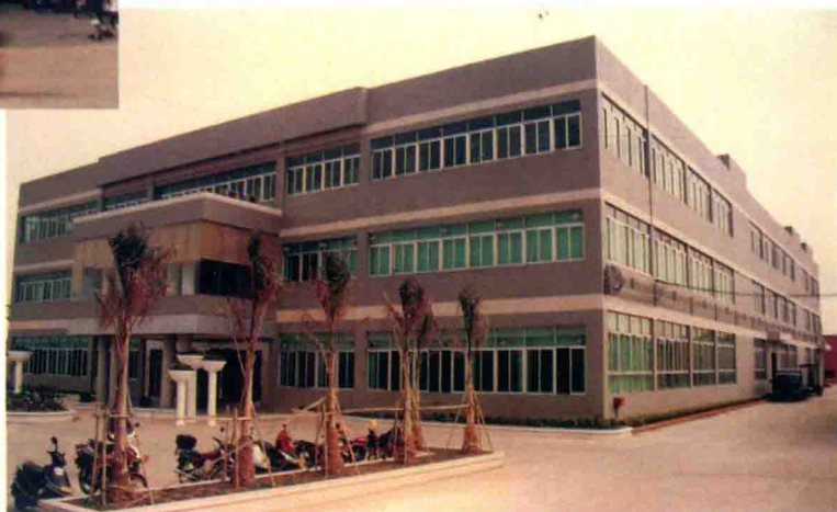
▶六建总公司承建的 台山市七洋灯饰厂房。
