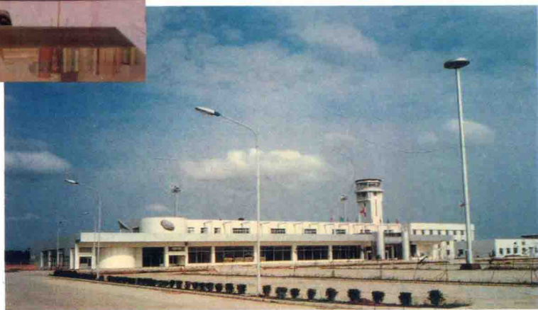
▶ 由一建集团公司装修的山东省临沂国际机场候机楼。
